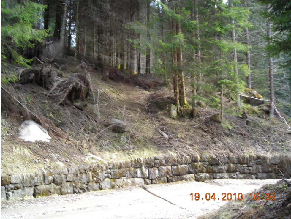
Figura 42. Altra vista ingresso condotta e cavidotti verso il versante a monte del tornante.
