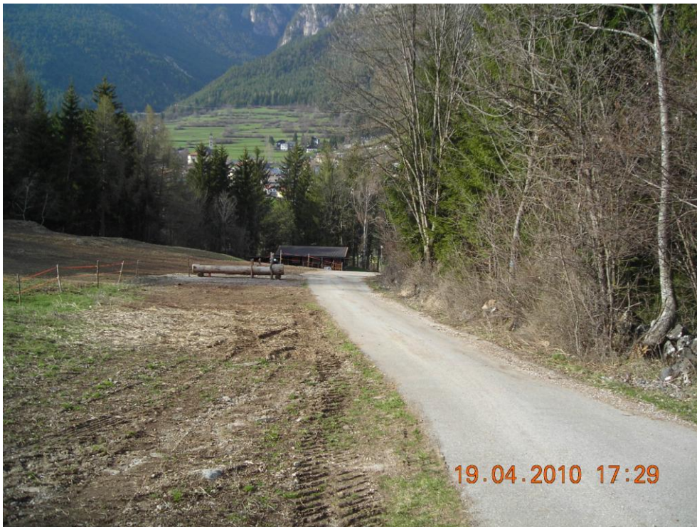
Figura 23. Posa condotta e cavidotti lungo strada comunale asfaltata.
