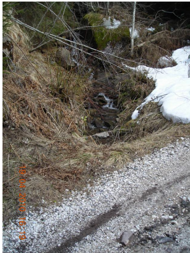
Figura 49. Posa condotta e cavidotti lungo strada bianca. attraversamento scolo in subalveo.
