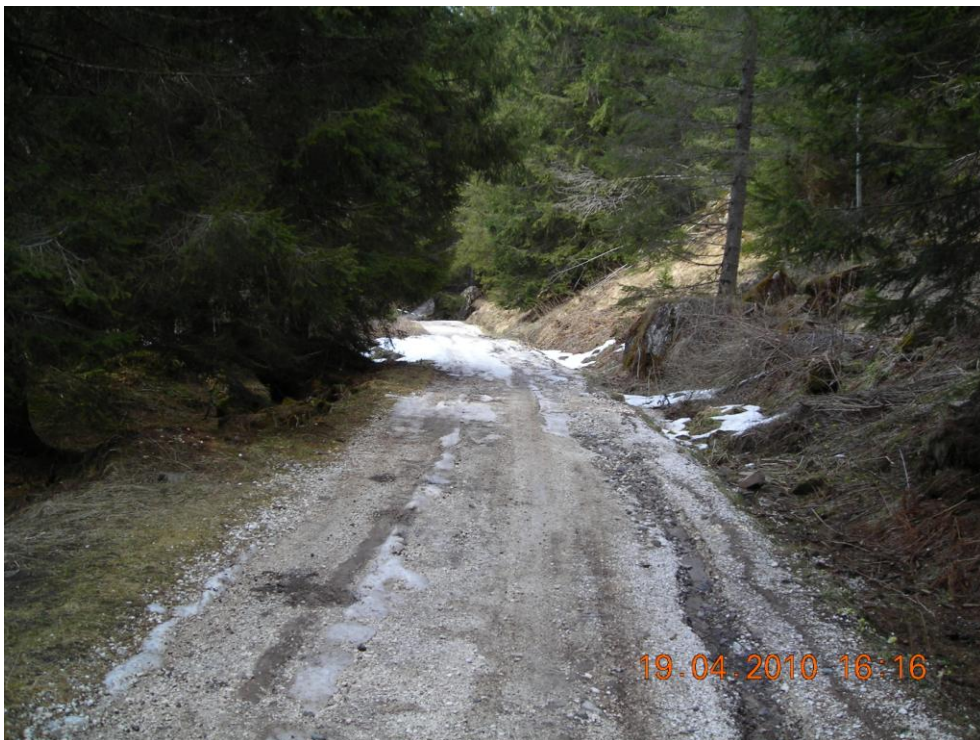
Figura 47. Posa condotta e cavidotti lungo strada bianca.
