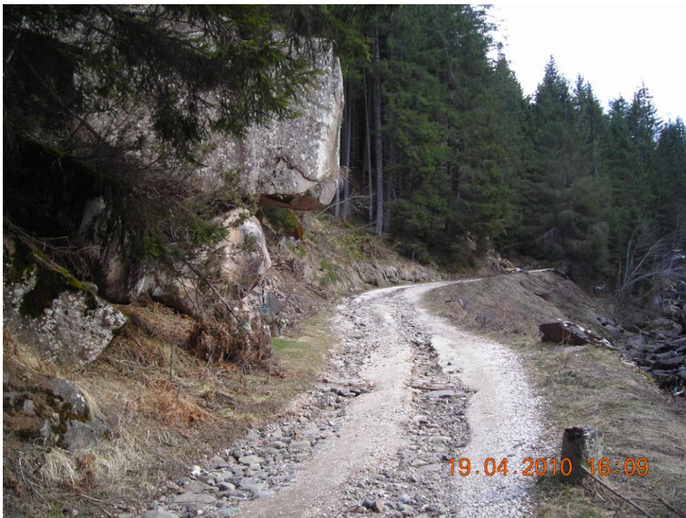
Figura 45. Posa condotta e cavidotti lungo strada bianca.
