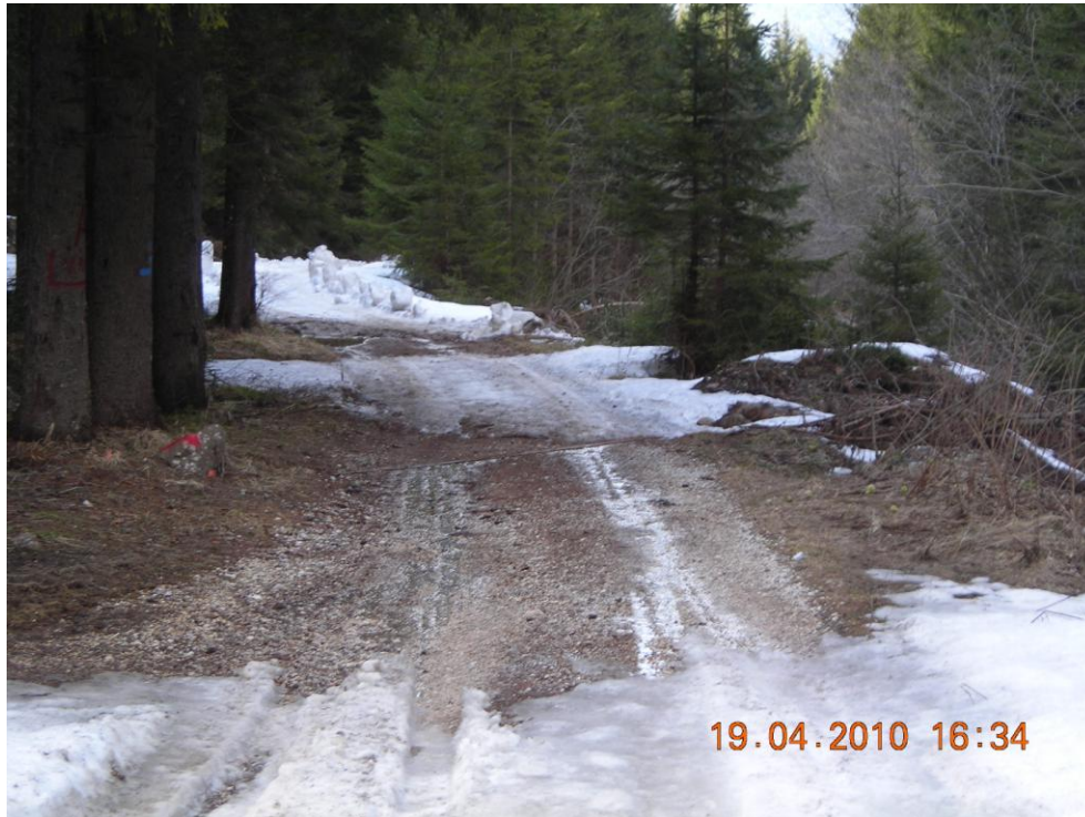
Figura 54. Posa condotta e cavidotti lungo strada bianca.
