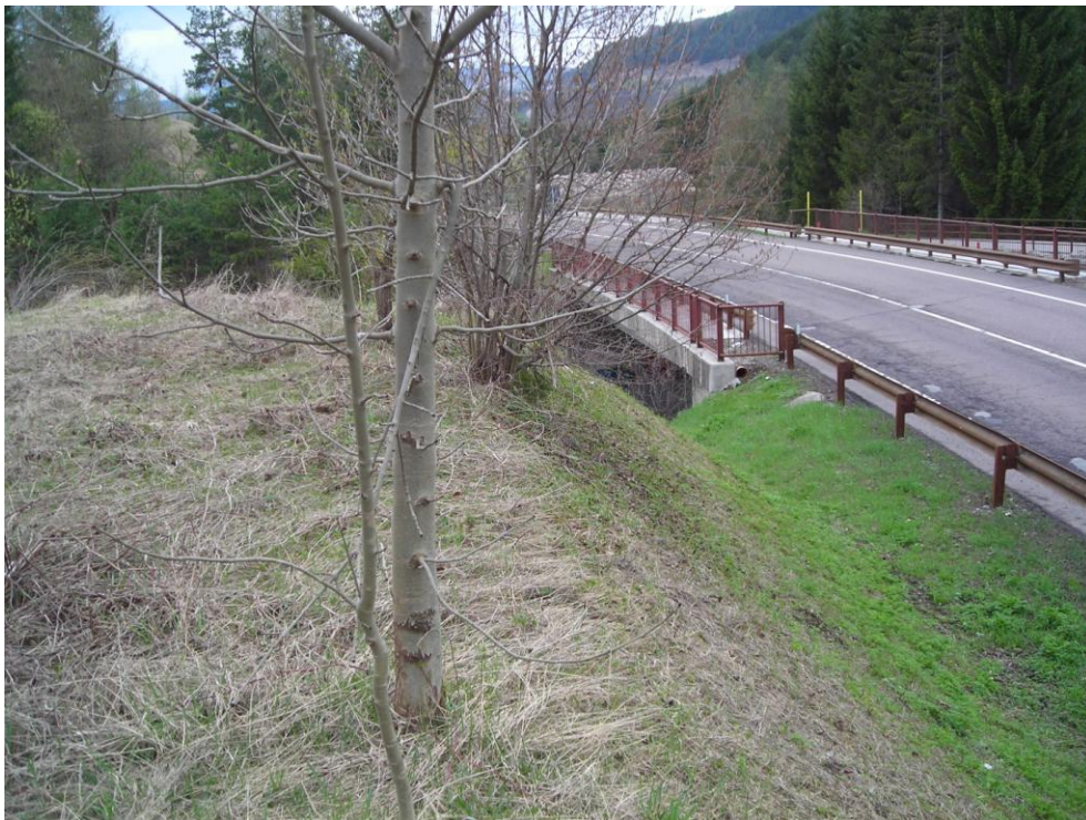
Figura 11. Rampa a monte della S.P. 232 di Fiemme – inizio posa condotta e linee elettriche a monte della S.P. 232 di Fiemme a carico del presente appalto.
