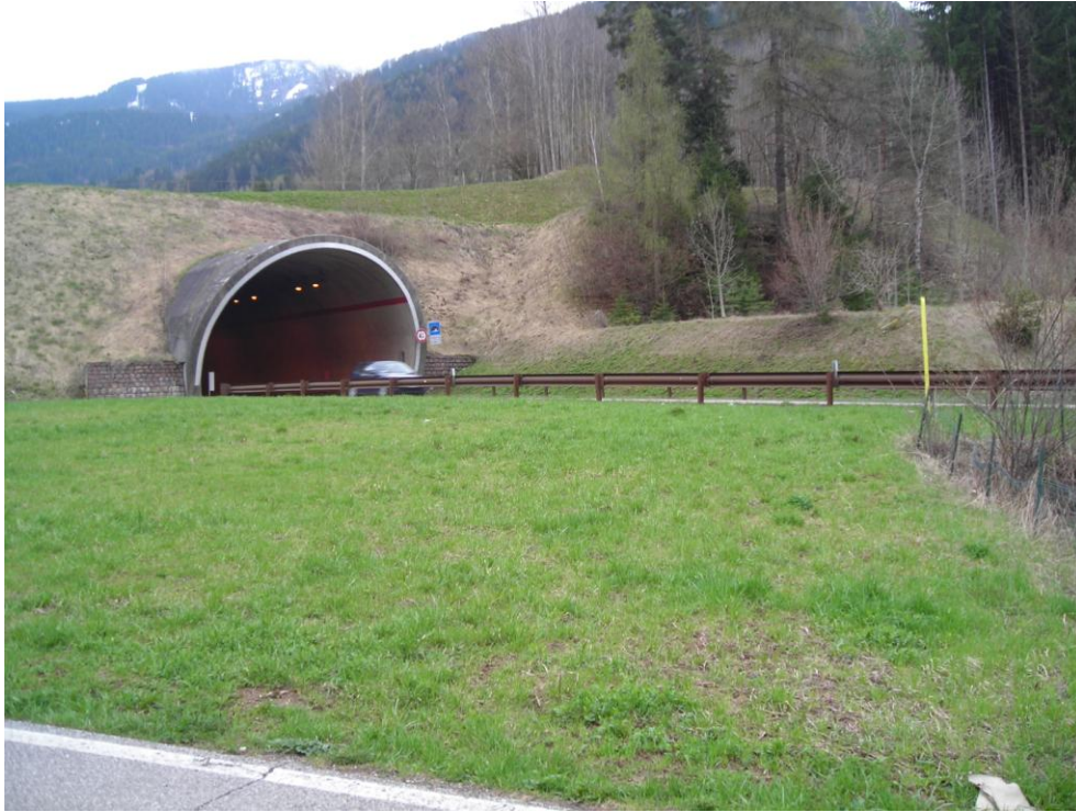
Figura 8. Piazzale adibito ad area cantiere a monte della centrale. La posa della condotta in tale tratto è a carico di appalto separato.
