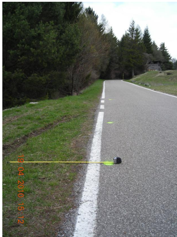
Figura 7. Posizione metanodotto nei pressi della centrale, a monte dello stesso.
