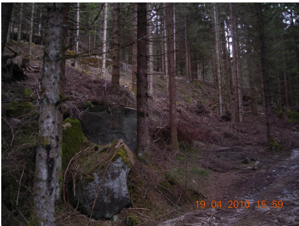
Figura 39. Passaggio condotta e cavidotti lungo versante a monte della stessa. A sx nella foto si nota il muro di sostegno della strada bianca forestale che porta in loc. Cavelonte.
