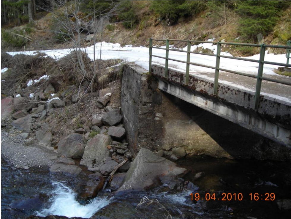
Figura 52. Particolare di valle ponte delle Mandre sul rio Cavelonte.
