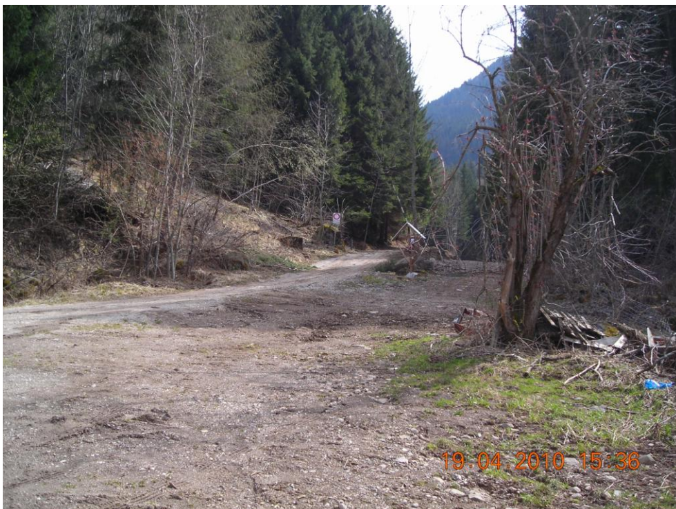
Figura 25. Inizio strada bianca ove è prevista la posa della condotta forzata e dei cavidotti.
