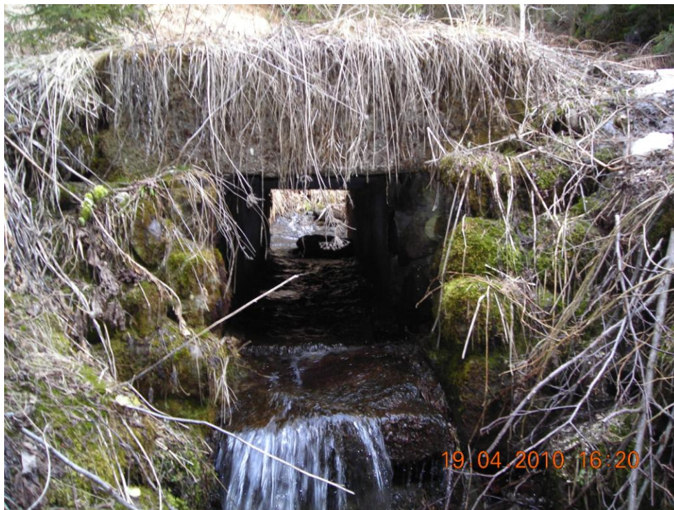
Figura 50. Particolare attraversamento scolo.
