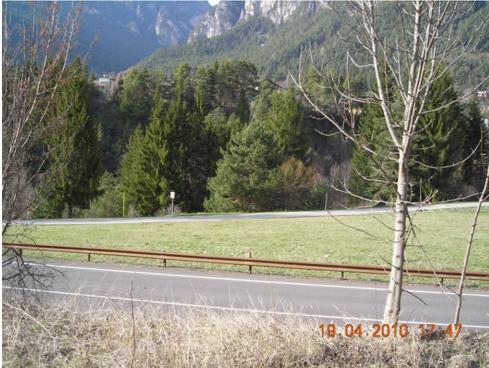
Figura 12. Vista d'insieme zona cantiere edificio centrale, tratto condotta, S.P. 232.
