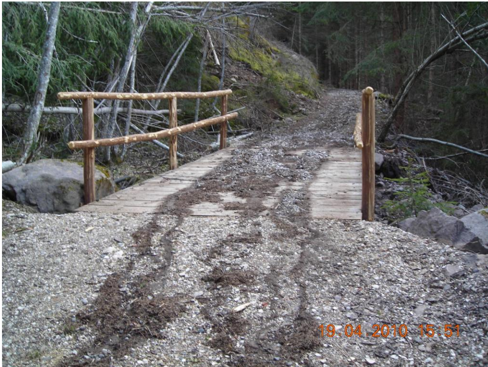
Figura 34. Ponte su rio minore lungo mulattiera. Previsto attraversamento in subalveo.
