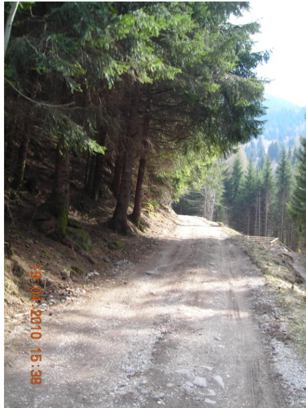
Figura 28. Posa condotta e cavidotti lungo strada.
