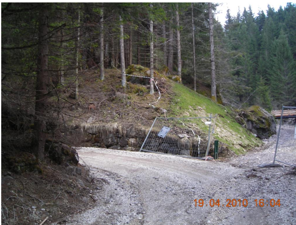
Figura 41. Posa condotta e cavidotti lungo strada e zona ingresso in area boscata in corrispondenza del tornante.
