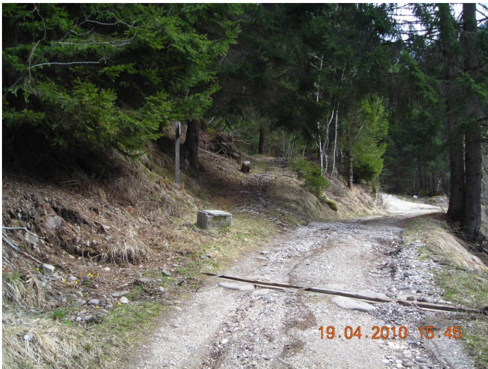
Figura 31. Inizio posa condotta e cavidotti lungo mulattiera a sx nella foto.
