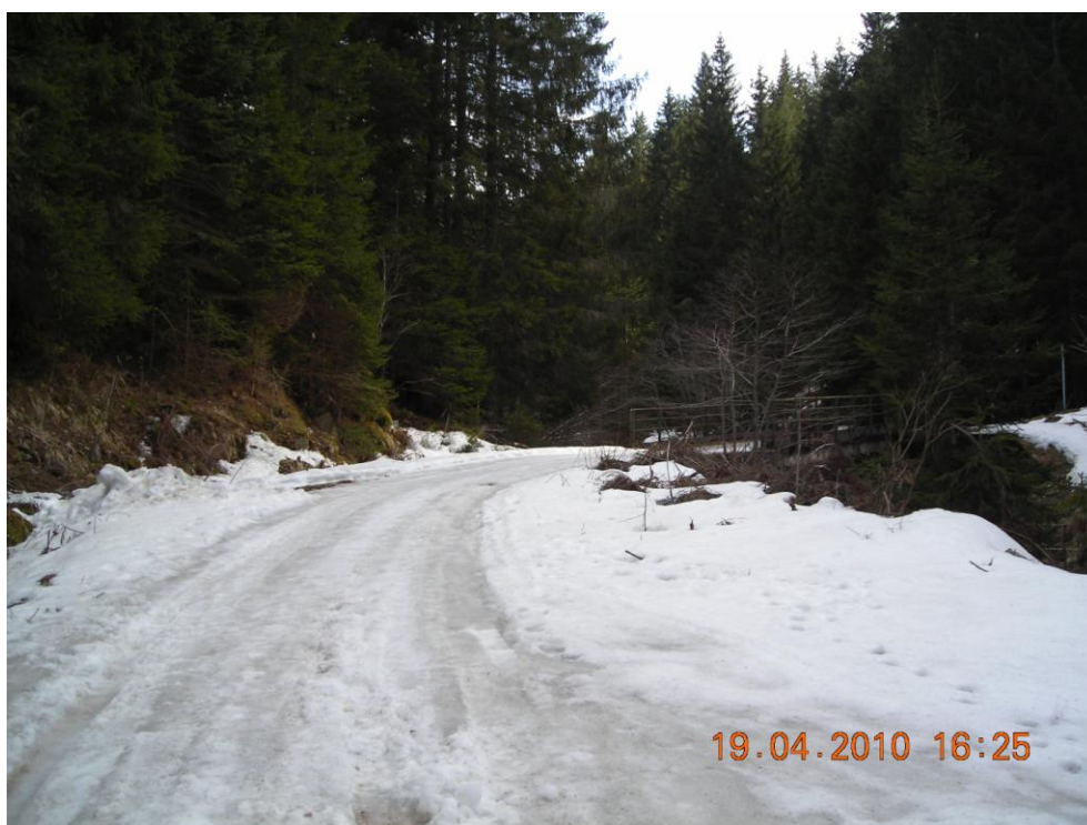
Figura 51. Zona attraversamento ponte delle Mandre sul rio Cavelonte con condotta a sbalzo.
