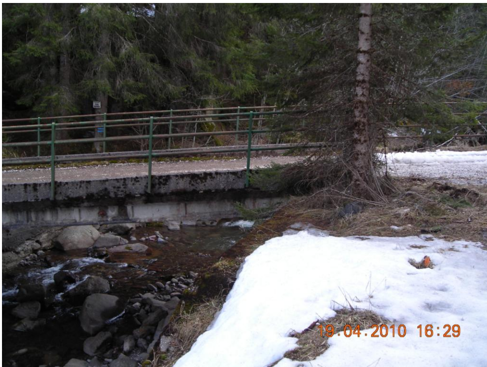
Figura 53. Particolare di monte ponte delle Mandre sul rio Cavelonte.
