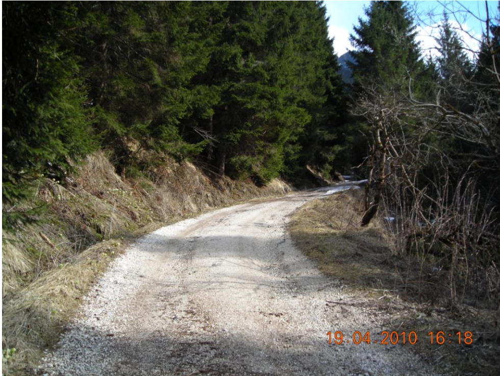
Figura 48. Posa condotta e cavidotti lungo strada bianca.
