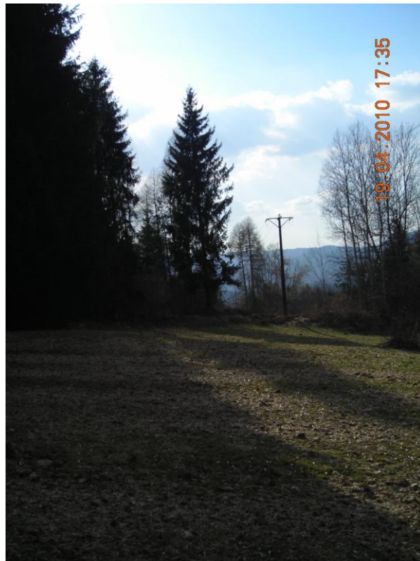
Figura 17. Zona a prato e linea elettrica aerea MT esistente.
