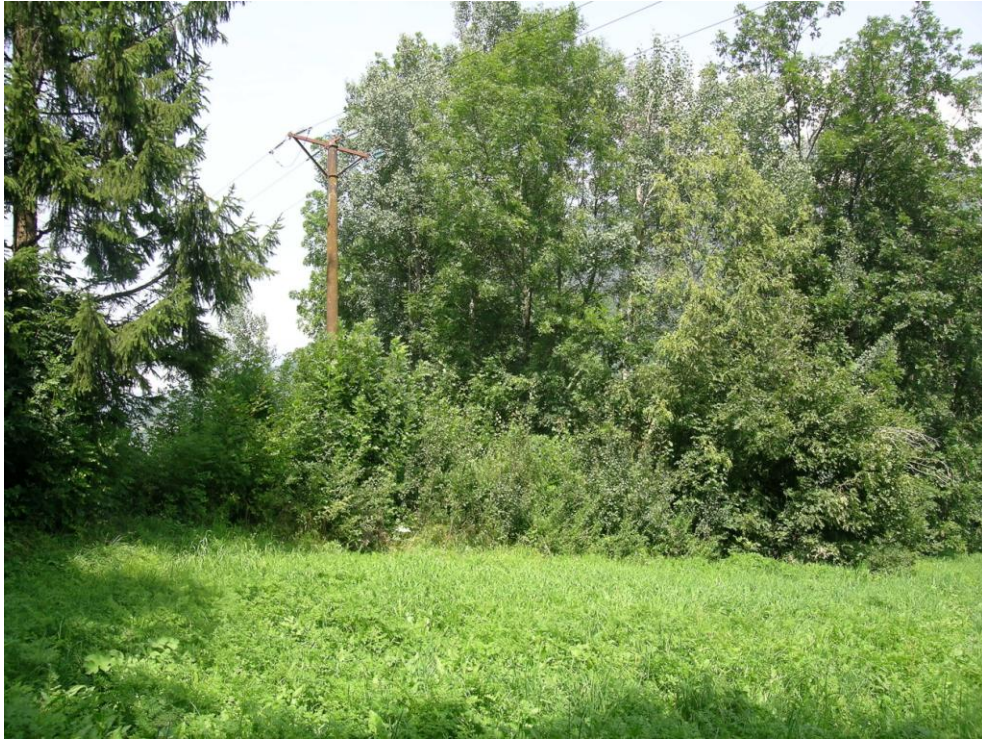
Figura 16. Inizio posa condotta e linee lungo prati. Presenza palo linea aera MT ove è previsto l'allacciamento dell'impianto alla rete elettrica di zona.
