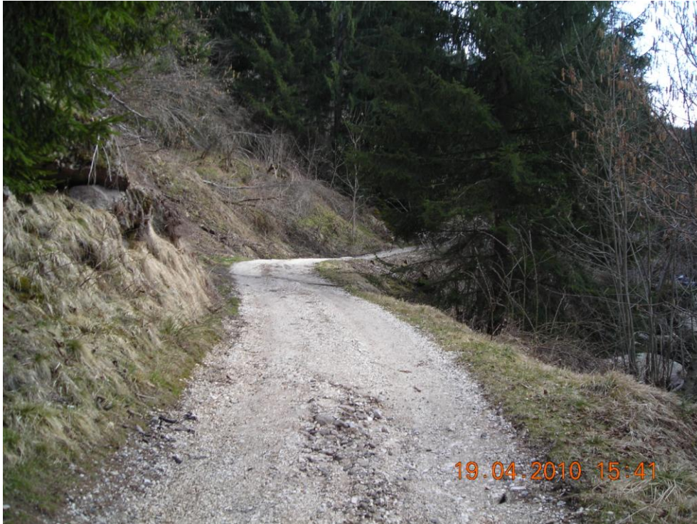
Figura 30. Posa condotta e cavidotti lungo strada.
