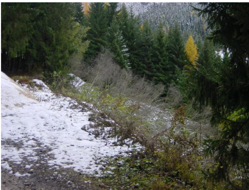
Figura 60. Rampa a valle ove è previsto il riempimento per spostare la sede stradale ed allontanarla dalla parete rocciosa instabile.
