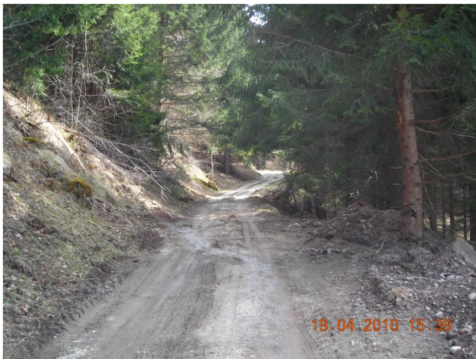
Figura 29. Posa condotta e cavidotti lungo strada.
