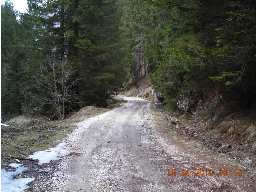
Figura 46. Posa condotta e cavidotti lungo strada bianca.
