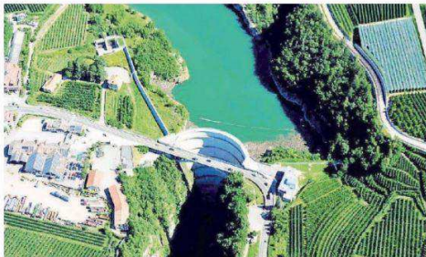
La diga di Santa Giustina potrebbe diventare un punto panoramico (foto Zanetti)
