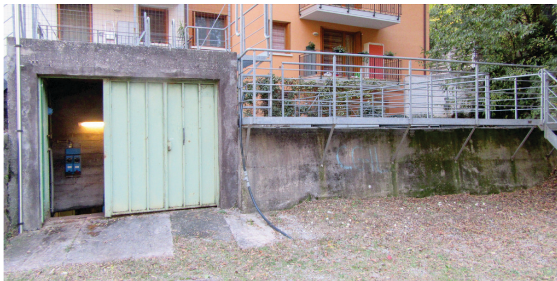
Figura 10 – Locale pompe e vasca di carico
