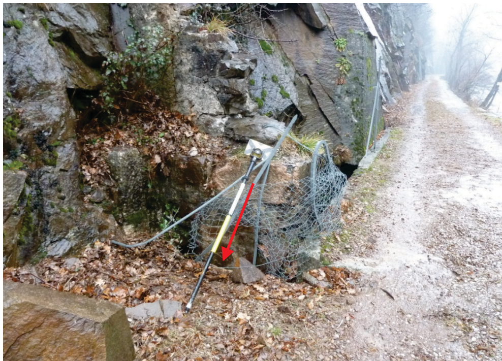
Figura 4 – Antico alloggiamento di paratoia di regolazione.
