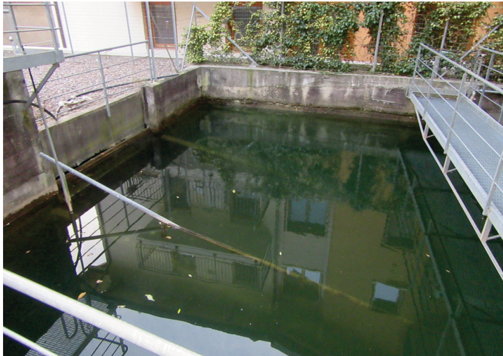
Figura 7 – Vasca di carico con scarico sfioratore
