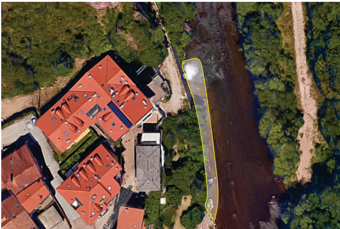
Figura 12 – Banco-scoiiera di accesso al canale di scarico.
