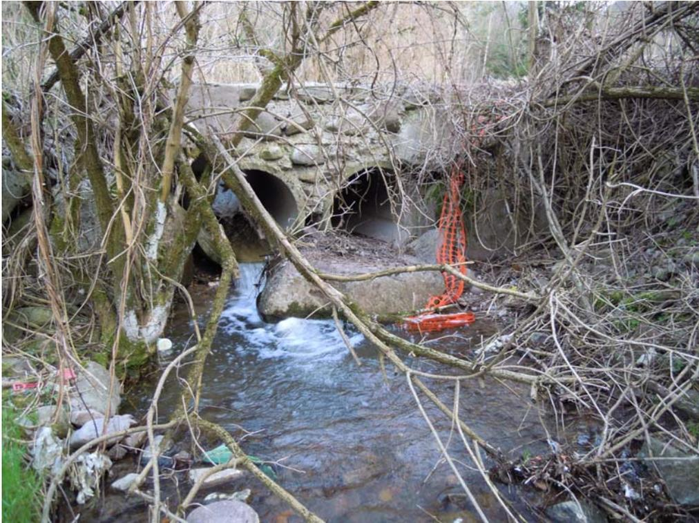
**Foto 18 - Le due condotte in cls in corrispondenza dell'attraversamento del piccolo corso d'acqua**
