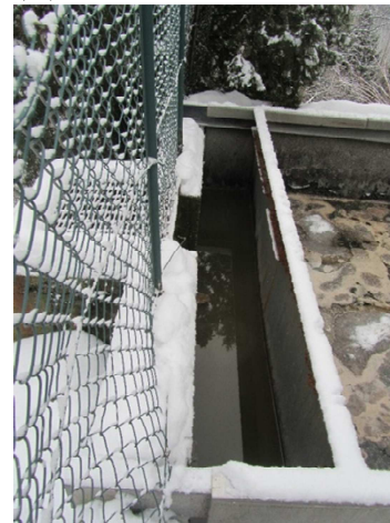
Figura 15. Vasca Imhoff di Valda: (A) foto di insieme; (B) scarico con lama paraschiuma.
