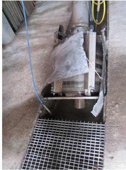
Figura 5. Filtrococlea nel locale grigliatura.
