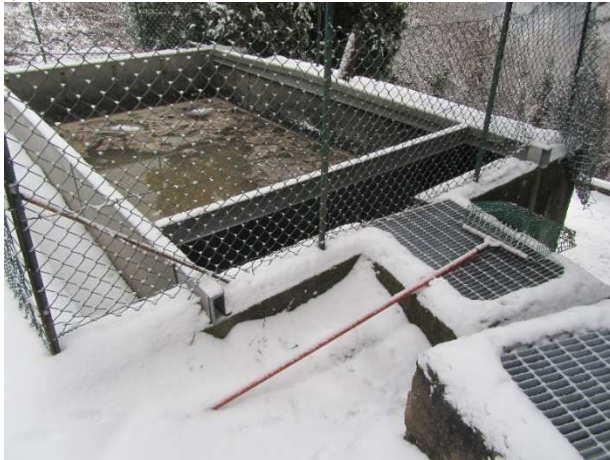
Figura 15. Vasca Imhoff di Valda: (A) foto di insieme; (B) scarico con lama paraschiuma.
