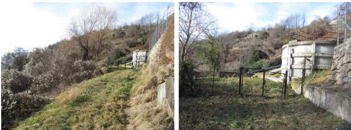
Figura 14. Strada di accesso all'impianto di Grumes Sud con vasca Imhoff in cls sul fondo e a destra.
