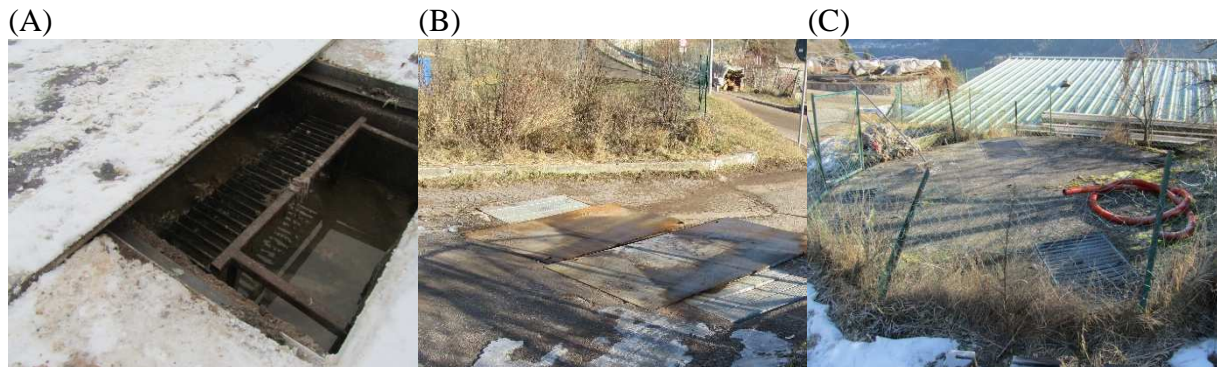
Figura 9. (A) Griglia grossolana di Grauno; (B) piastre metalliche amovibili per la copertura della canaletta di grigliatura; (C) vasca Imhoff.
