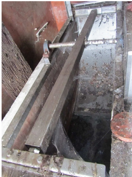
Figura 11. Grumes Nord - griglia ad arco, non utilizzata.
